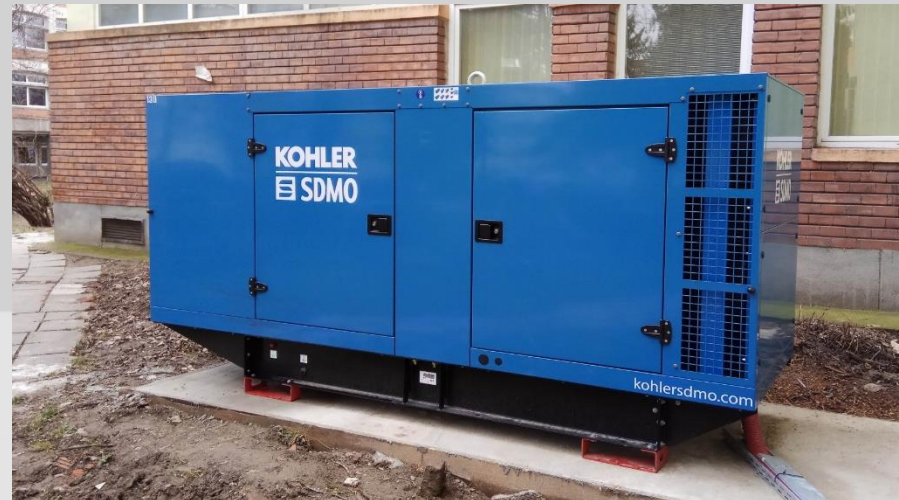
Echipamente ale RoEdu utilizate în comun cu UPT Grup electrogen de 120KVA, 96kW
