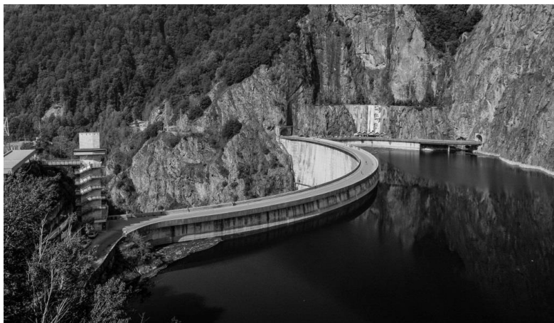
Barajul și lacul Vidraru
